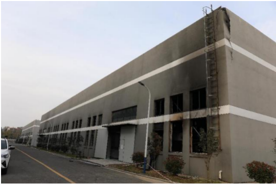
图3 事故厂房外立面
