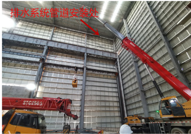
图1 排水系统管道安装作业面
