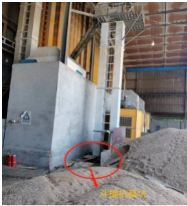
图5 事故点斗提机基坑现场照片
