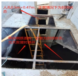
图6 事故点斗提机基坑照片
