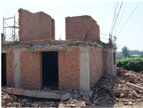
图3 31#住宅楼既有现状
