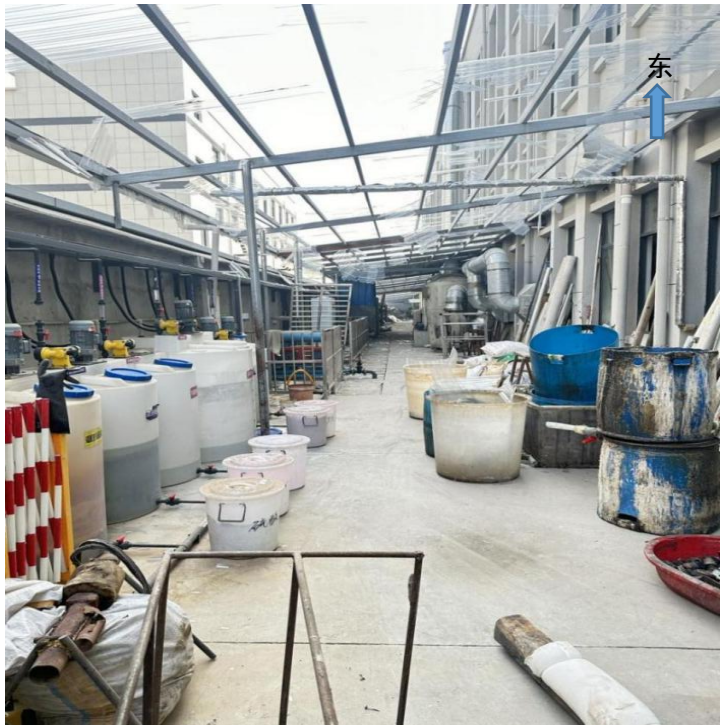
图 3 污水处理站现场图
