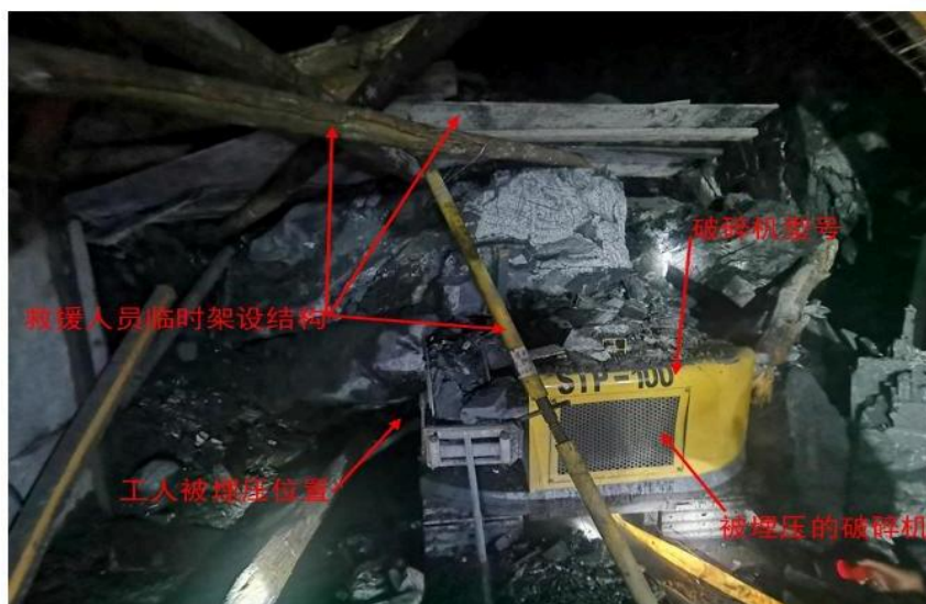
图 4 抢险救援搭建临时支护
