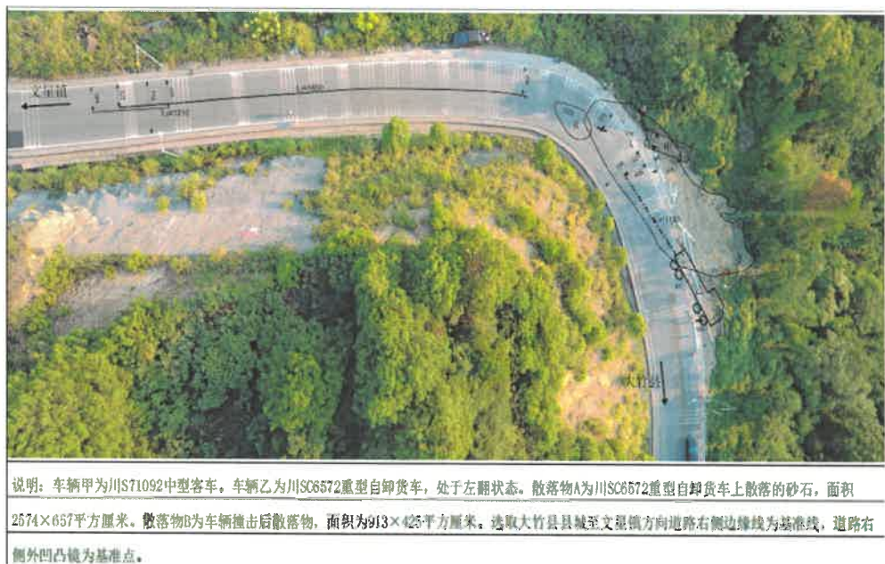
图3 现场道路情况俯视图
