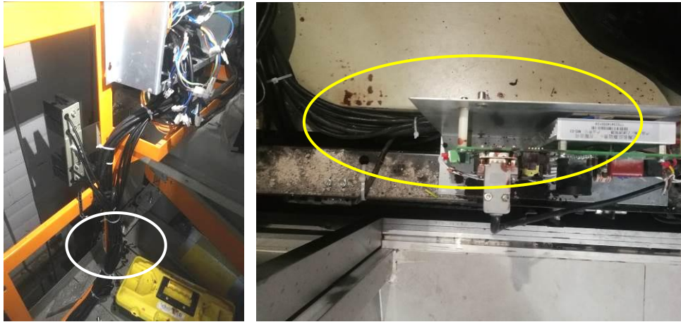
图3 电梯轿厢顶部血迹勘查
