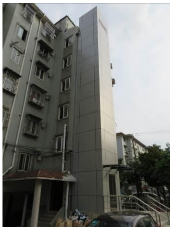
图1 涉事加装电梯（56号楼）
