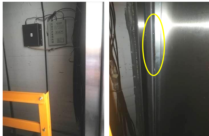
图4 电梯井道壁及层门内侧勘查
