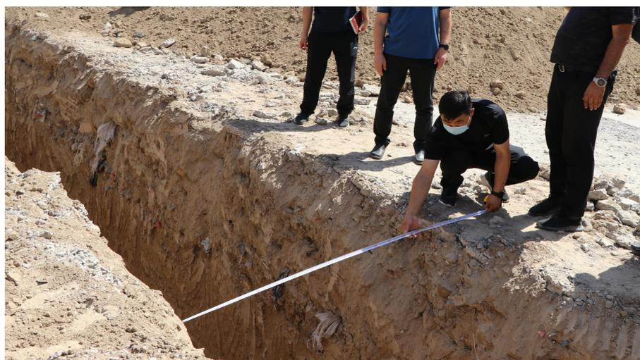
图4 上口开挖宽度测量现场
