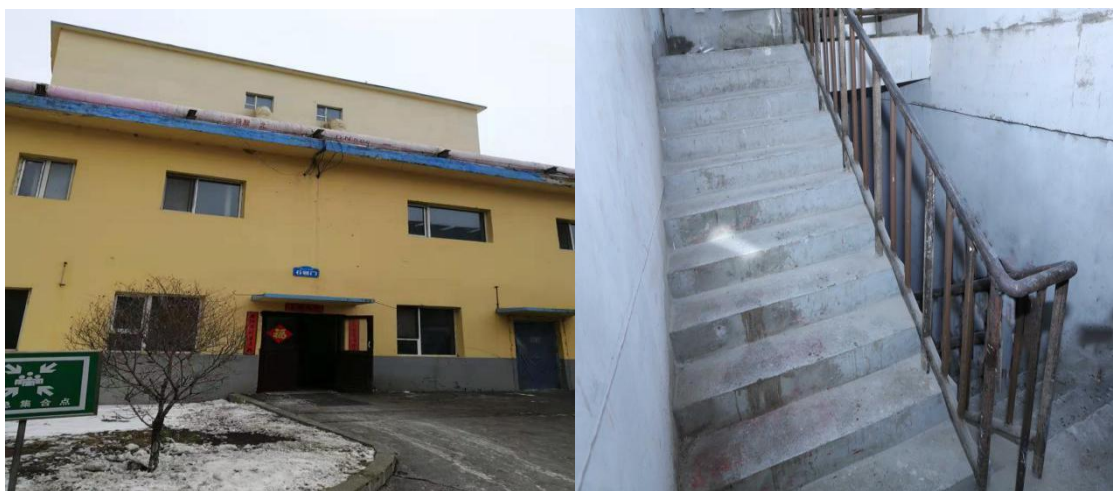
图一 长丝八车间 6 号门及三楼楼梯间
