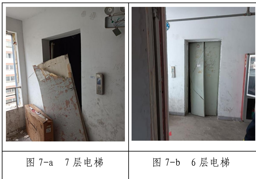
图 7 7 层、6 层电梯受损图
