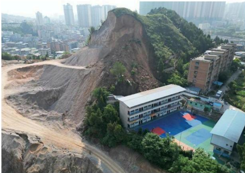
图 2 第三期土石方项目事故发生后图片
