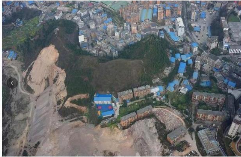
图 1 第三期土石方项目未开挖前航拍
