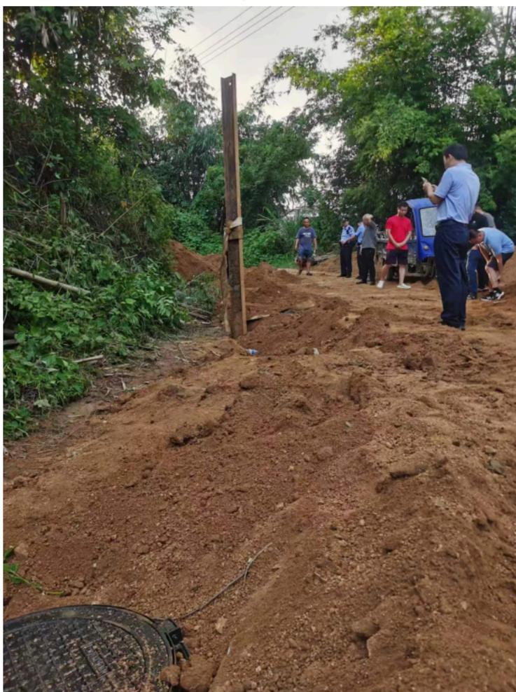
(图2) 坍塌路面填埋处
