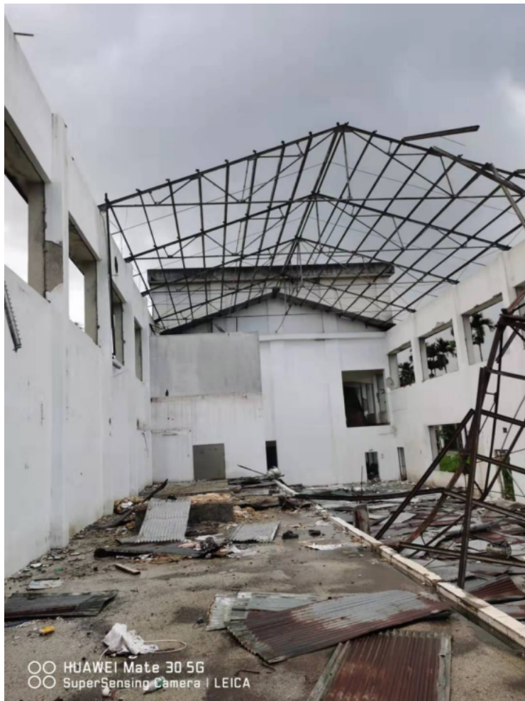
尚未拆卸下来的铁架（图八）
