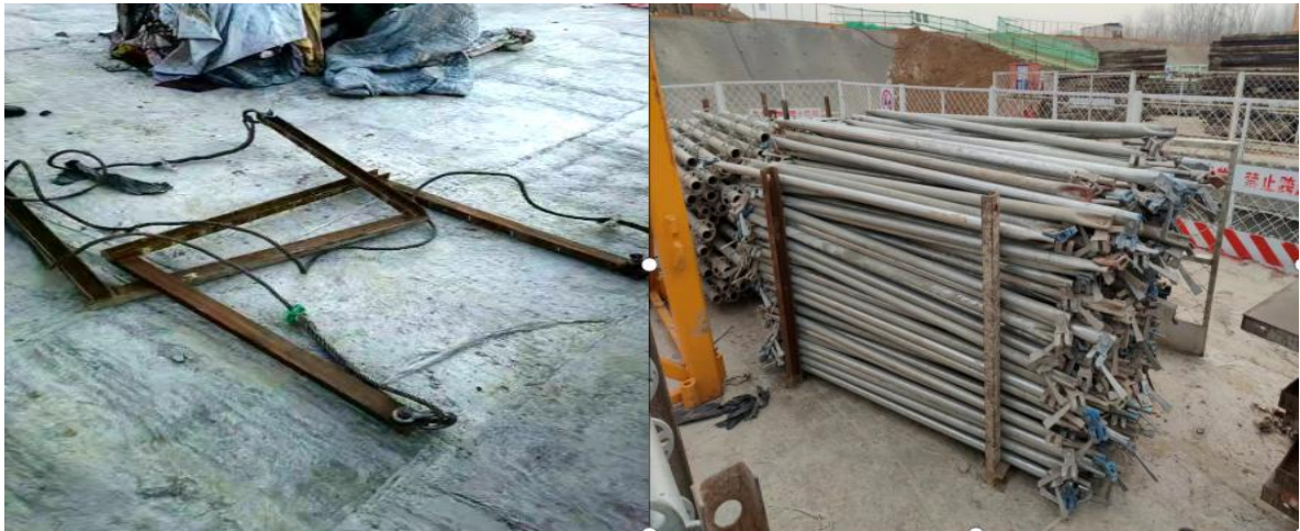
图 5. 事故 U 型吊具及同类型吊装物
