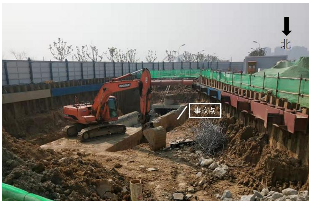
图 2 雨水箱涵破除施工现场全貌
