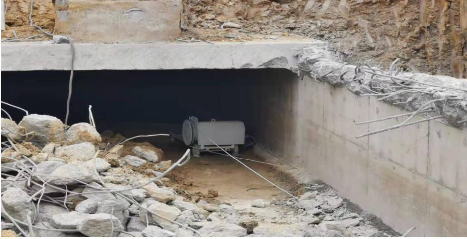
图 3 雨水箱涵内绳锯破除现场
