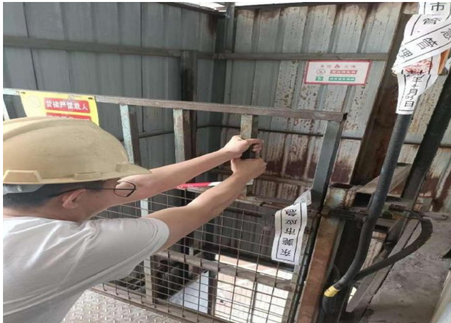
图 15 现场测试防护门照片
