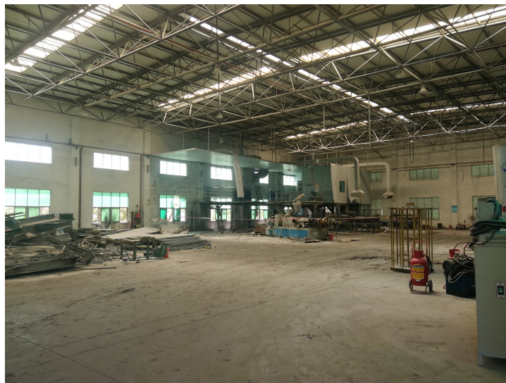
图 1: 事故发生地塑料车间全貌
