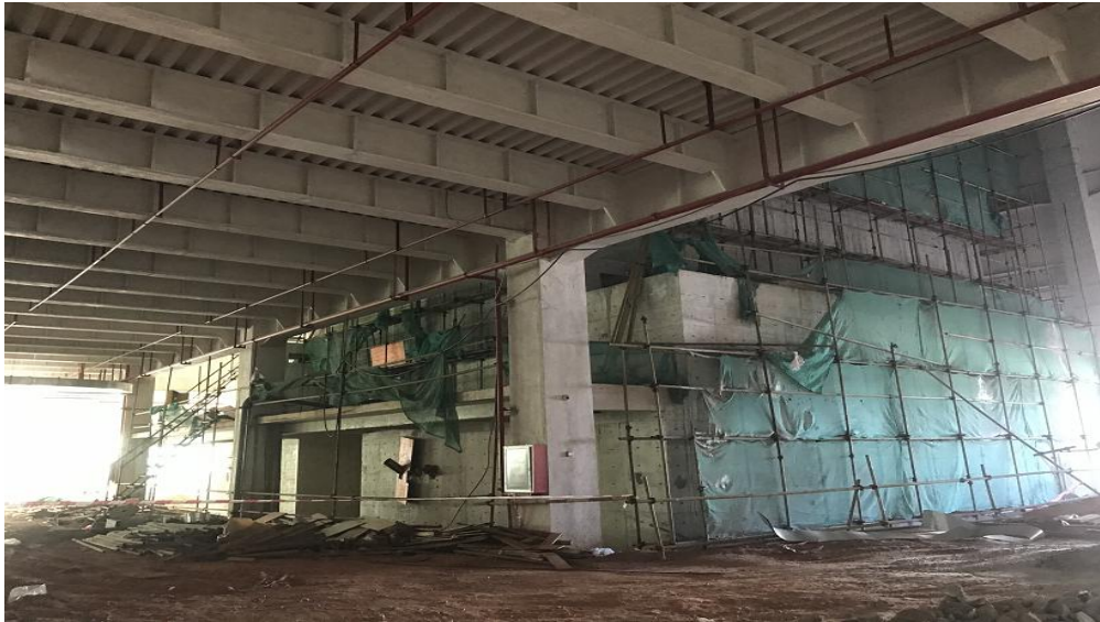
图5 事故后现场辐照车间地面图（未作水泥硬化）
