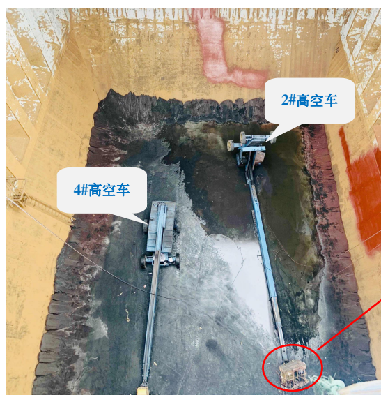
图 1 事故现场俯视图
