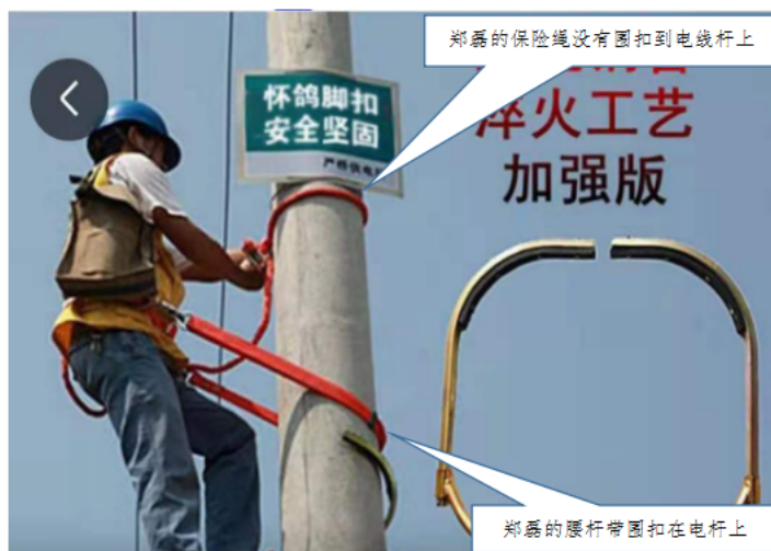
图7 郑磊只扣安全腰杆带，不围扣保险绳示意图
