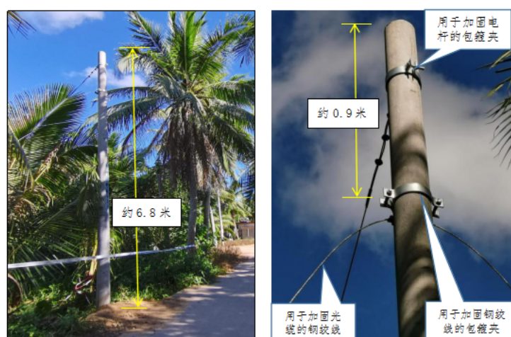
图2 事故发生的023号电杆
