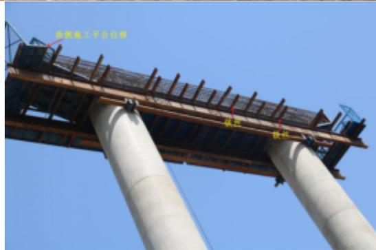
图2（坠落的东侧施工平台）
