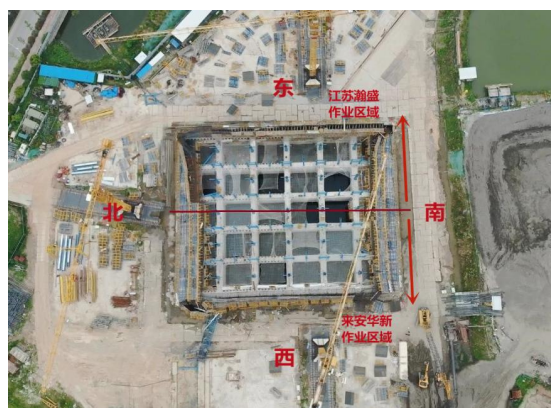
图7 南锚碇沉井现场航拍图
