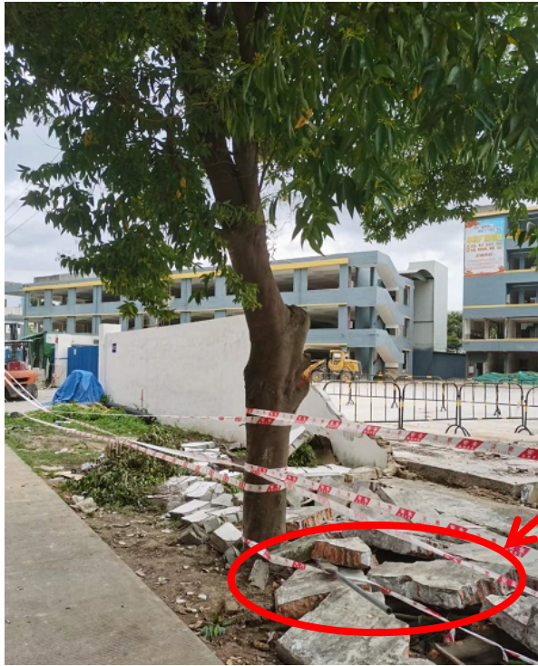
图 1：围墙倒塌现场
