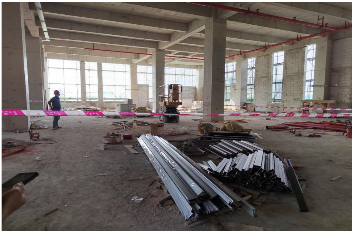
图 2 事故发生所在楼层现场
