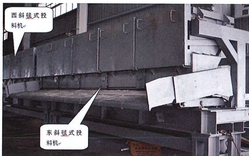
图 2 东西斜毯式投料机检修所处位置
