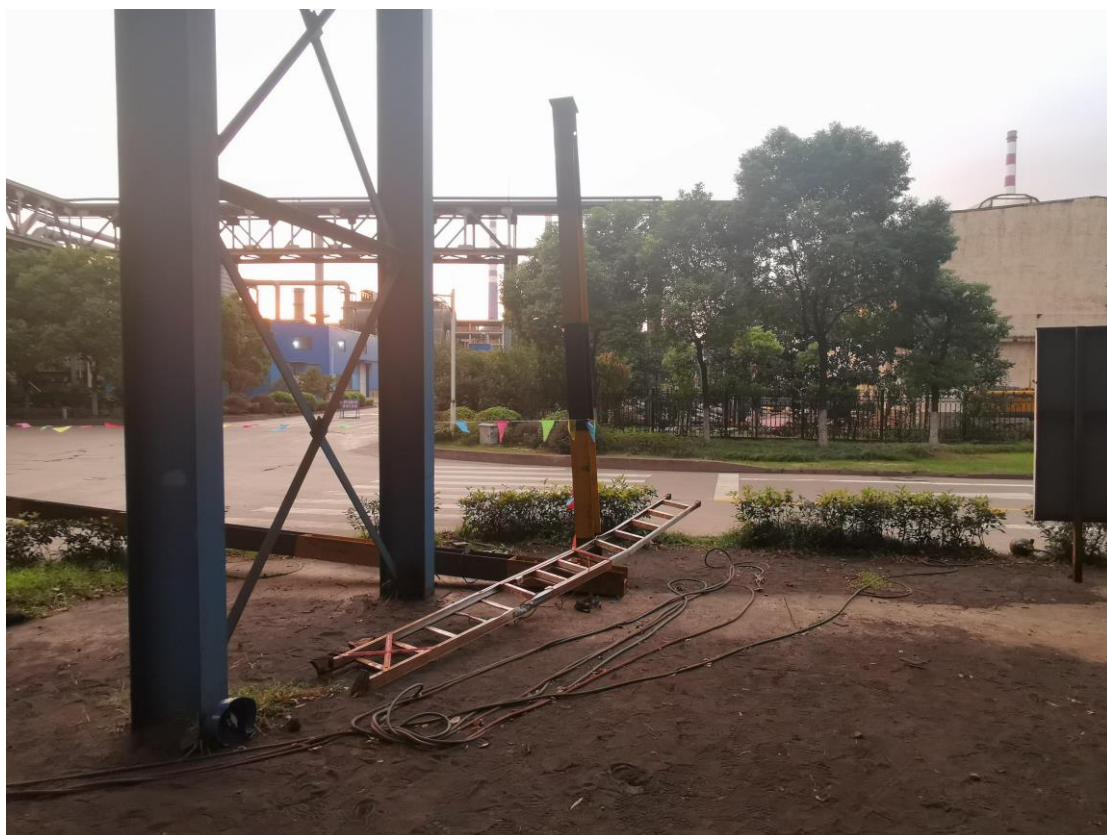
图七 防撞梁北端立柱
