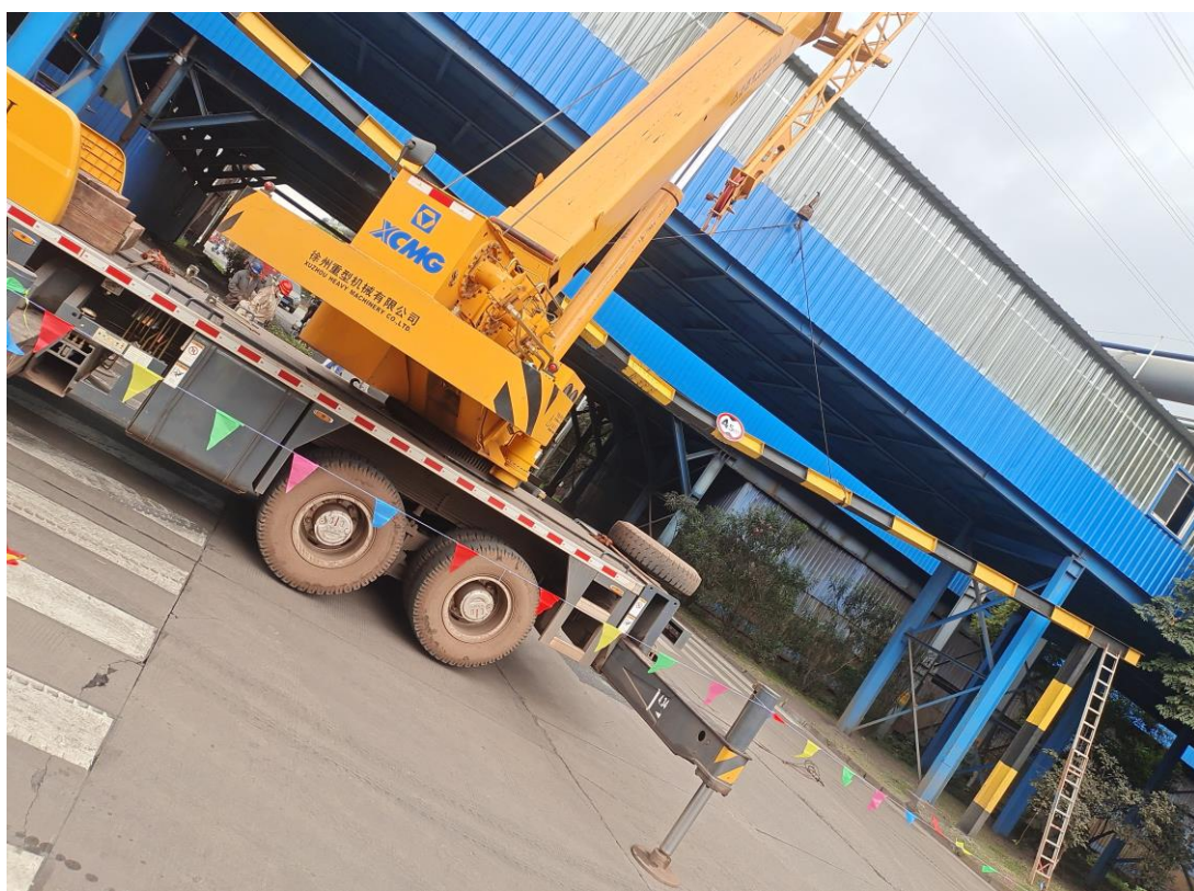
图十 事发前汽车吊作业情况
