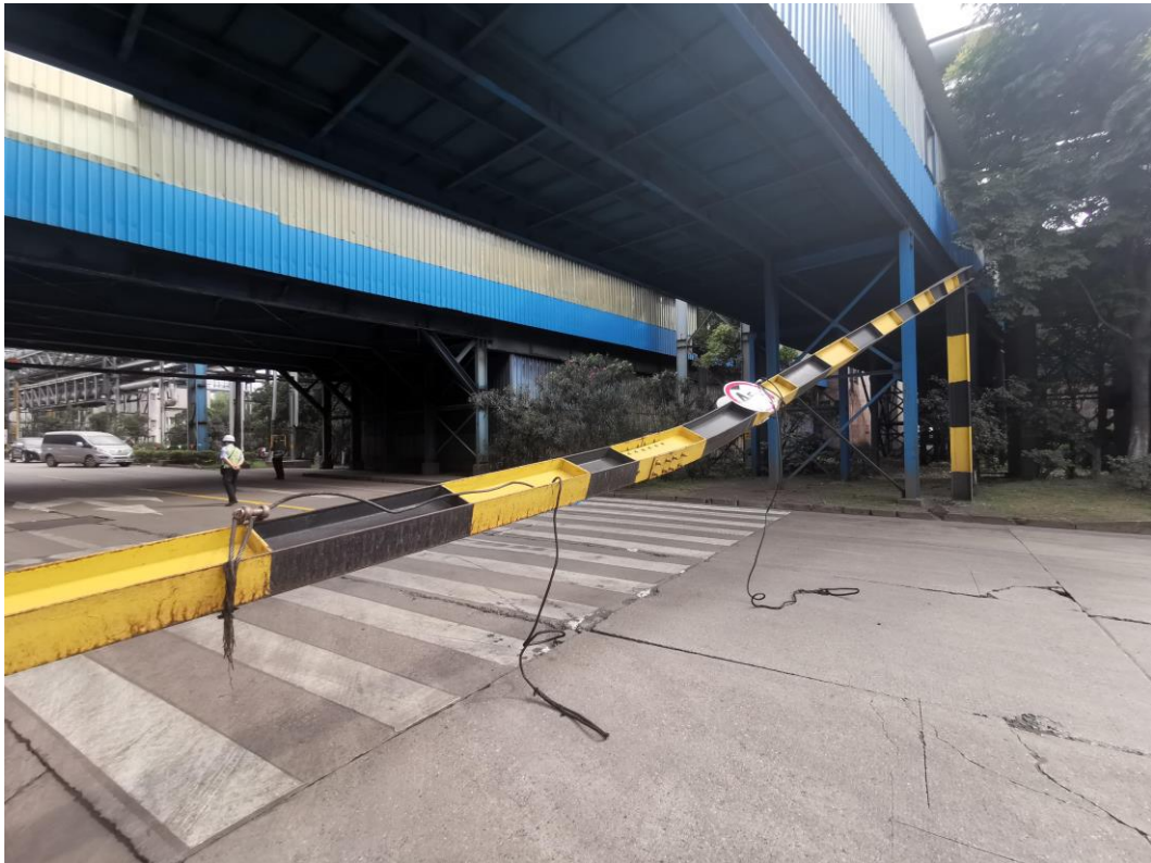
图四 横梁中部
