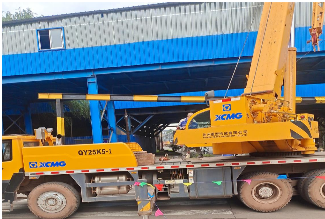
图九 事发前汽车吊作业情况
