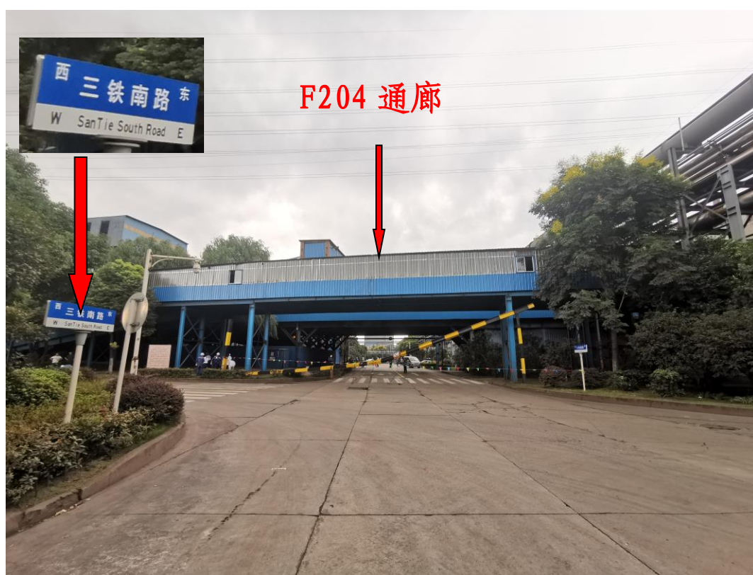
图一 马钢北区三铁南路与烧结南路交叉口（事故发生地）
