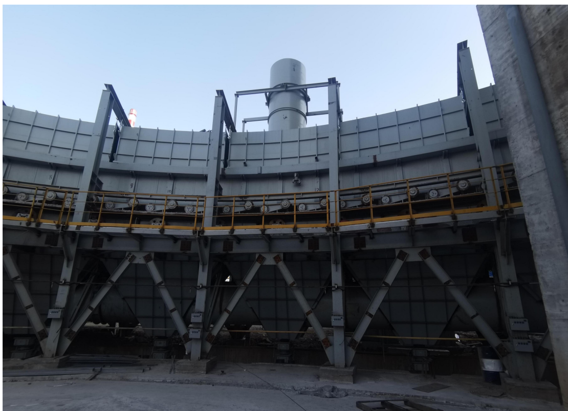
图四: C#烧结机环冷机内侧框架
