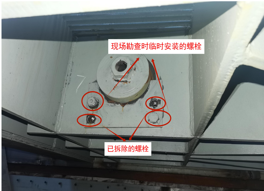
图十四：固定 7#台车的 V 型卡板情况
