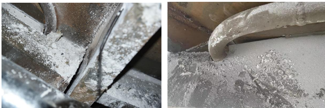
图 13 事故 D 灰斗加劲肋之间、加劲肋与壁板之间焊缝破坏情况
