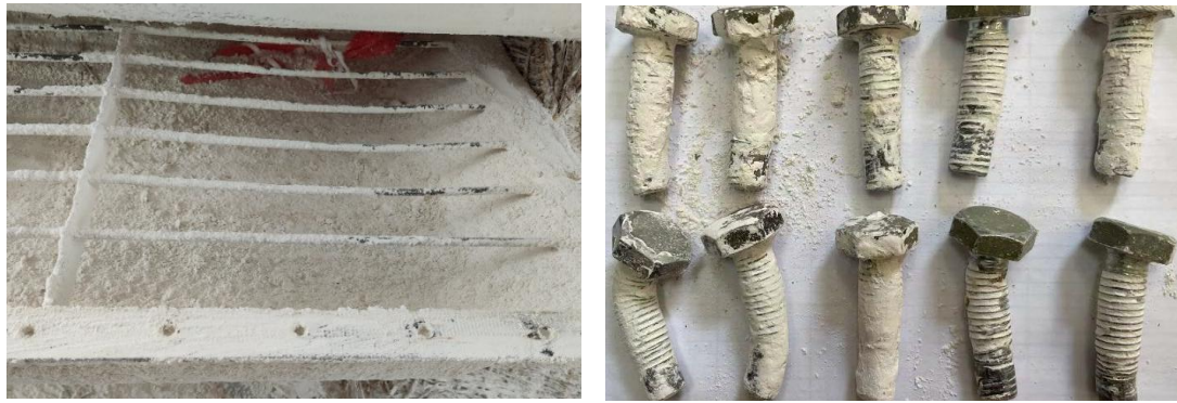
图 17 事故 D 灰斗底部流化槽破坏情况
