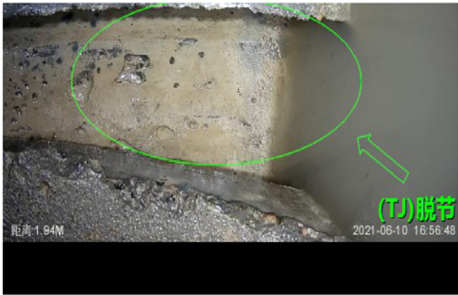
图 6 创新二路直径 500mm 的涵管脱节
