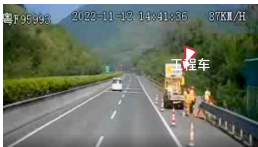
图 6 防撞警示车位置（位于应急车道内）
