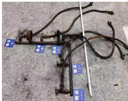
图4 事故现场汇流排直角阀
