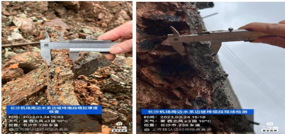
图3 喷射混凝土厚度现场检测照片
