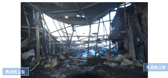
图9 新建冷库排酸间西北角立柱位置
