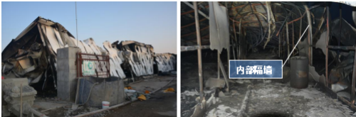
图4、图5 外墙、屋顶和内部隔墙情况
