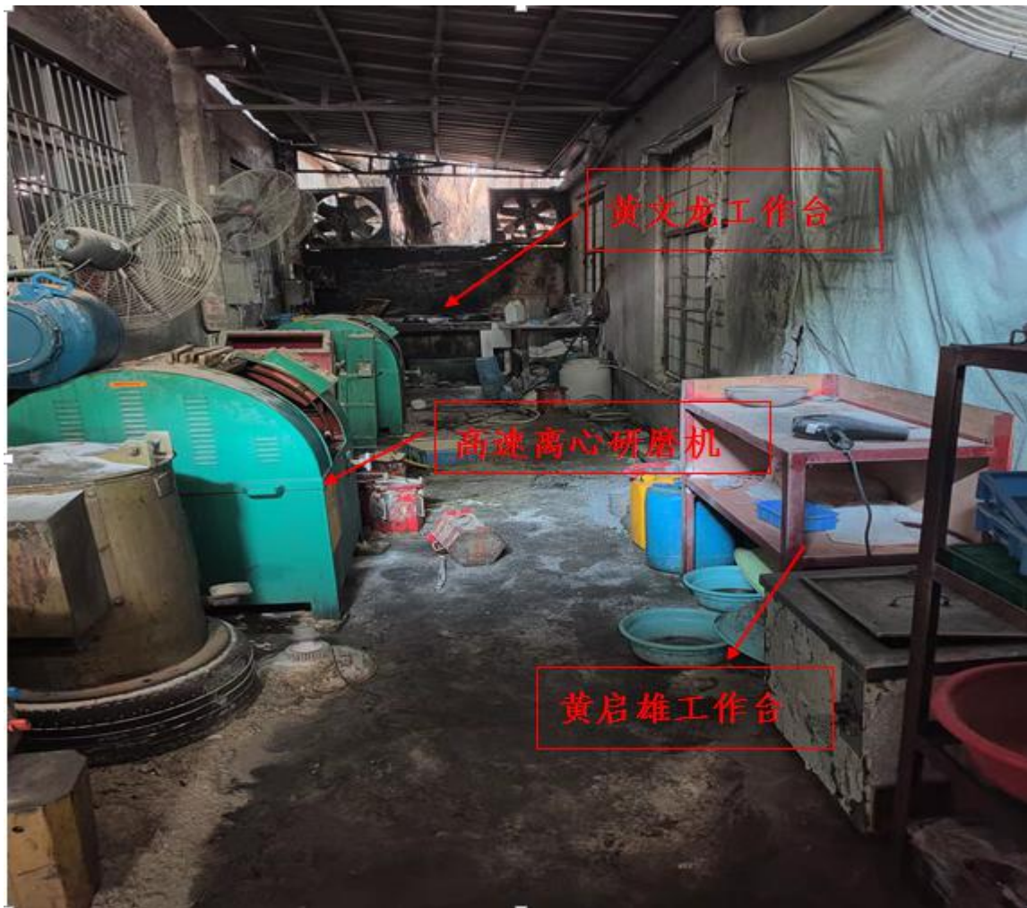
图 5 事发车间（研磨间）设备设施情况
