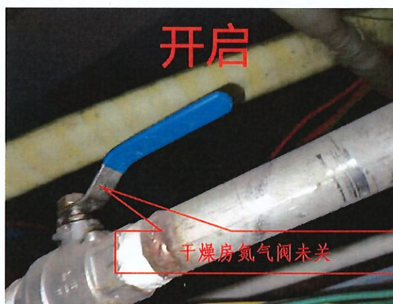
图 11 干燥房氮气阀
