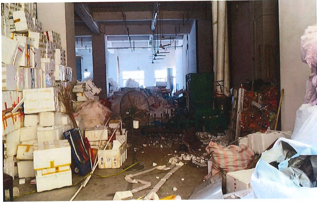
图 1 事故现场概貌图
