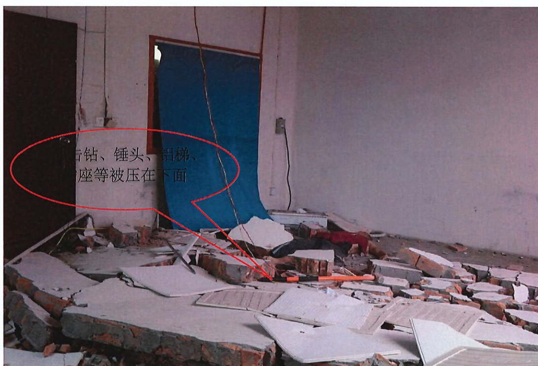
图3 熊代书被倒塌的墙体压到胸部以下的位置
