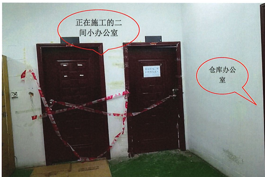
图2 事故现场位于四楼仓库办公室旁的二间正在施工的小办公室内
