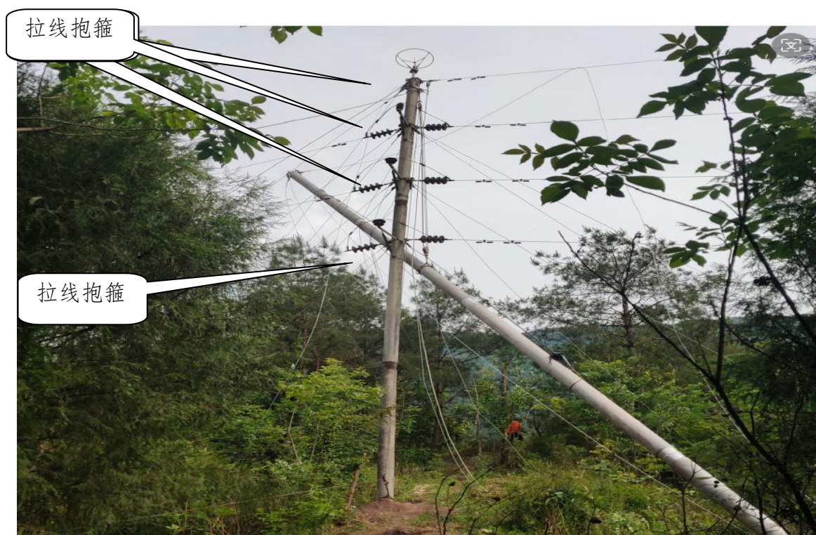
图 14 3#原电杆拉线抱箍和拉线
