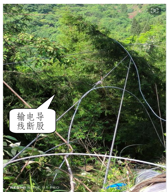
图 5 输电导线断股情况
