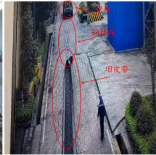
图4 铲车拉拽C104旧皮带现场图片
