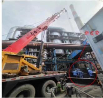
图3 吊车吊C104新皮带现场图片
