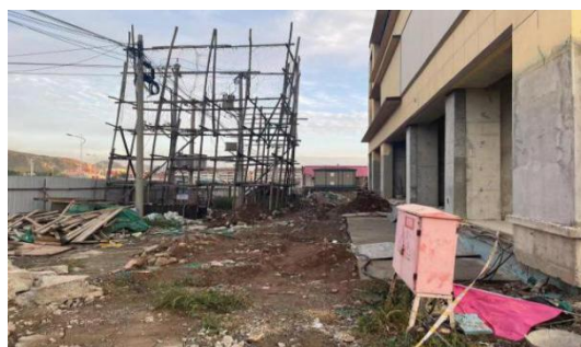
图 6 开挖沟槽边的变压器
