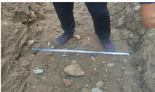
图 9 沟槽边坡及宽度
