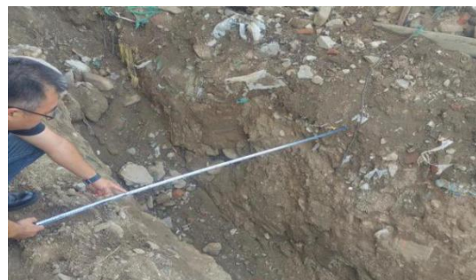
图 10 沟槽底部平整
