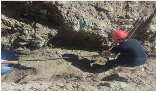
图 7 沟槽底部的旧房基础
