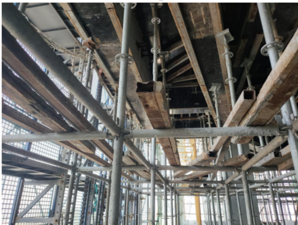
图 8 29 层拆模作业现场
