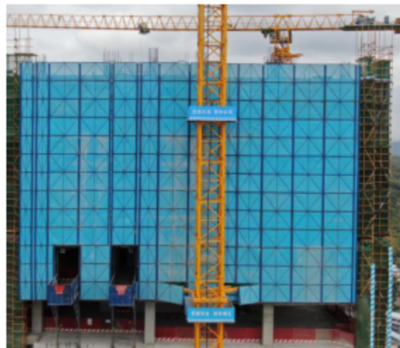
图4 28-31层爬升式脚手架外立面无穿透和破损痕迹
