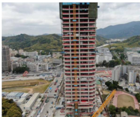
图3 28层以下临边防护无损坏
