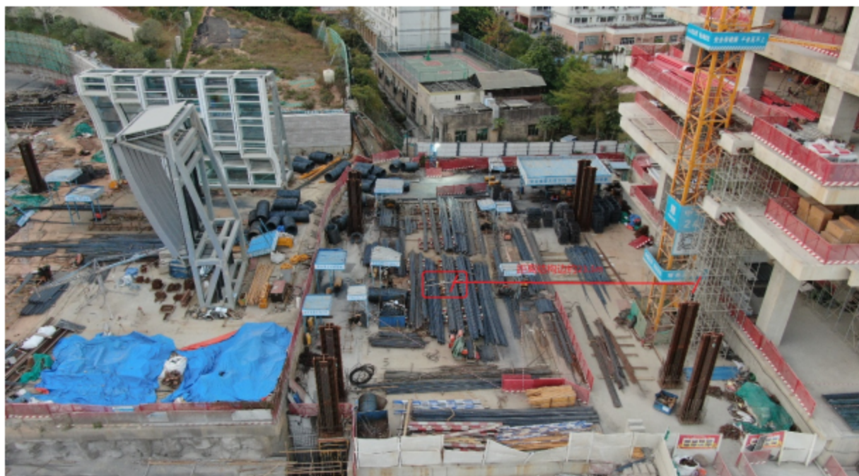
图 1：1#综合楼西侧与钢筋加工场
