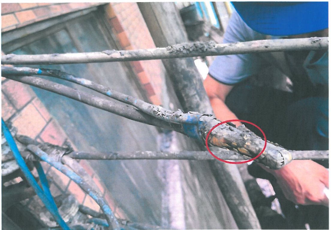
图 7 其余的接线头经检查绝缘基本完整
