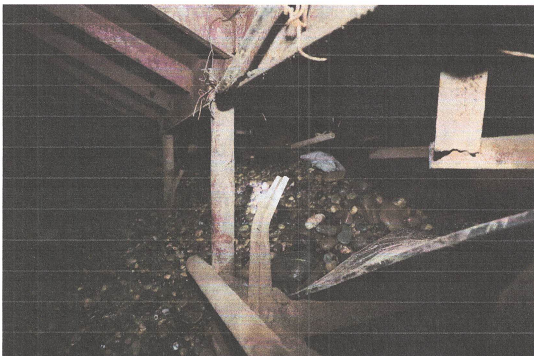
中心现场下方载料仓下层船舱内传送带概貌
