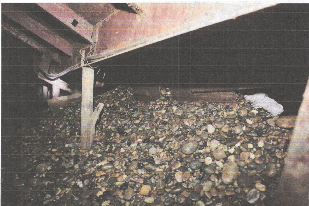
中心现场下方载料仓下层船舱内卸料口概貌
