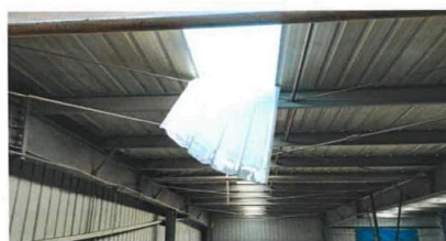
图5 采光瓦折弯后状况图
