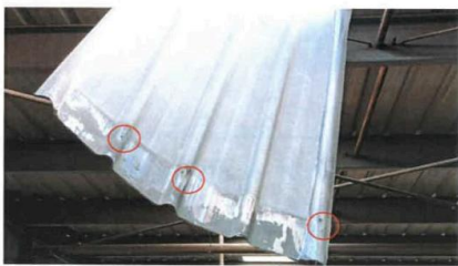
图6 采光瓦上的螺丝孔
