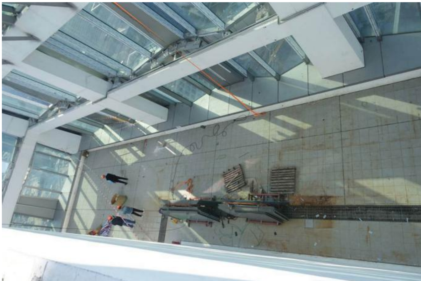
图2：56楼的幕墙施工材料
