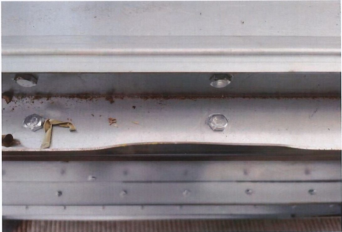
图 6：吊物棱角约为 15 毫米宽的钢铁构造
