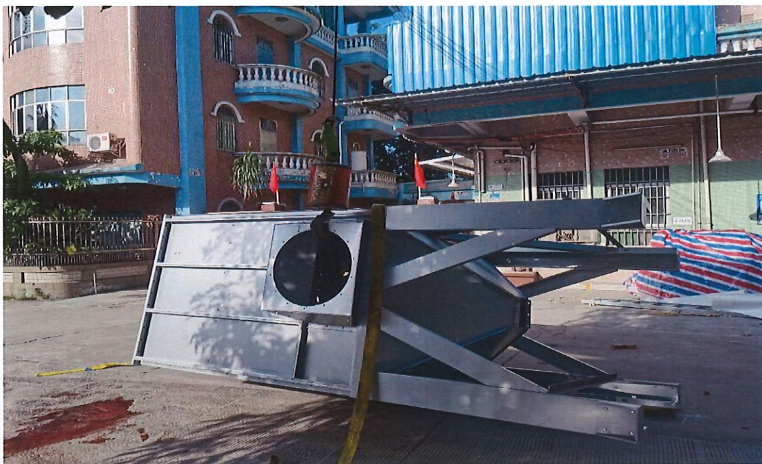
图 2：涉事吊物（除尘器）
