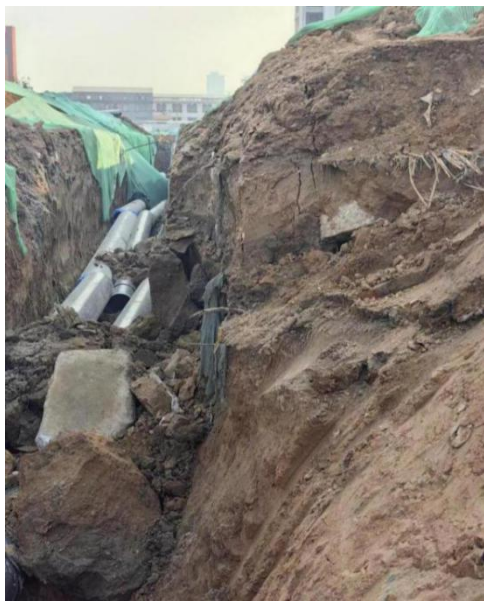
图 4 废弃化粪池处现场勘查
