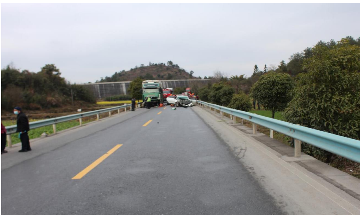
图 3、图 4：事发路段平整无坑槽、标志标线、安防设施完好
