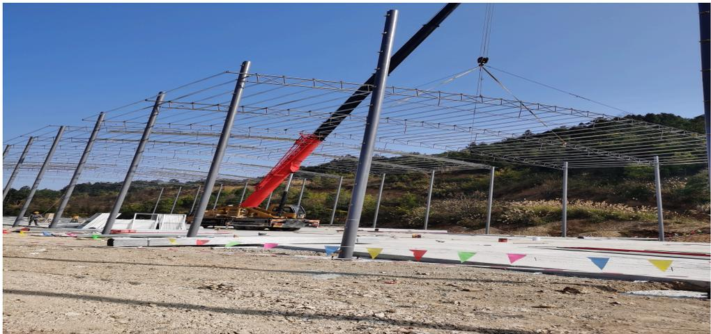
图3: 钢架棚安装作业面
